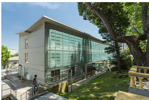
(a) Edificio de apoyo al estudio
